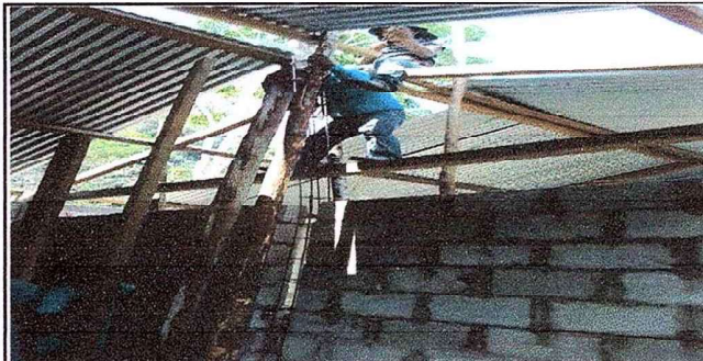
Foto 2: Division de las aulas.
